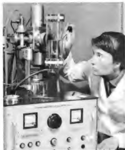
Mit Hilfe einer Spezialanlage werden im Laboratorium Hamburg Gold-Elektroden auf eine Halbleiterprobe aufgedampft
