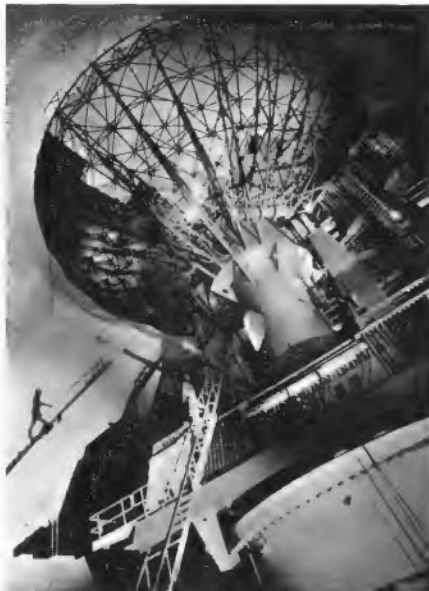
Im oberbayerischen Raisting geht die erste deutsche Satellitenfunk-Bodenstation ihrer Fertigstellung entgegen. Unser Bild zeigt einen Blick in das Innere der großen Rundhalle (Radome) mit der Antennenanlage in einem bereits weit fortgeschrittenen Stadium ihres Aufbaues
