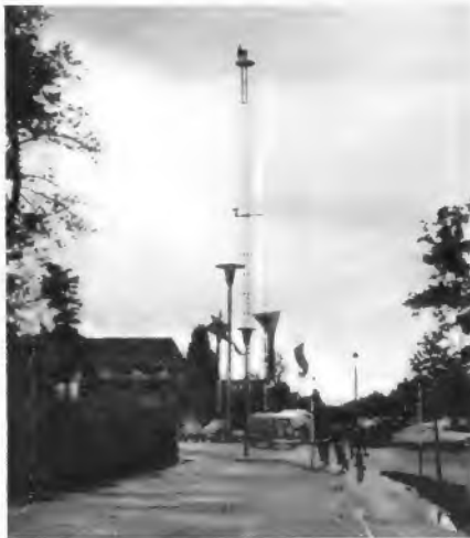
Bild 1. Mast mit Fernsehanlage der Polizei am Pferdeturmkreisel in Hannover
