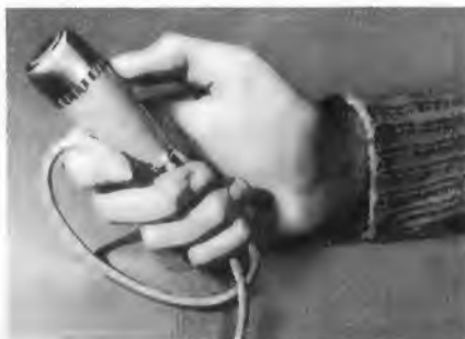
Bild 1. Das Tauchspulenmikrofon M 64 von Beyer für Sprachübertragungen hat eine unauffällige schlanke Form
