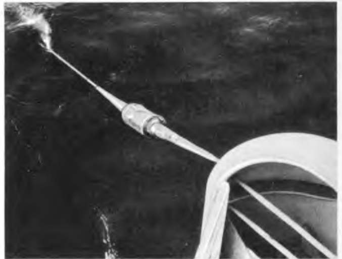
ICECAN Verstärker während der Legung
