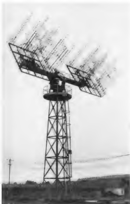
Bild 1. Eine von Wisi gelieferte Antennenanlage für 250 MHz. Sie dient zur Ionosphärenforschung am Max-Planck-Institut in Lindau am Harz
