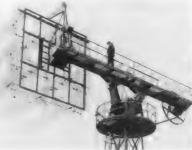
Bild 3. Die Abmessungen der Anlage läßt dieses während des Baues aufgenommene Bild erkennen. Die Sendeantenne ist fertig montiert. Rechts sieht man den Drehkranz für die Polarisationsänderung der Empfangsantenne. In der Mitte befinden sich die Schwenkgelenke und die Drehvorrichtung für die Gesamtantenne
