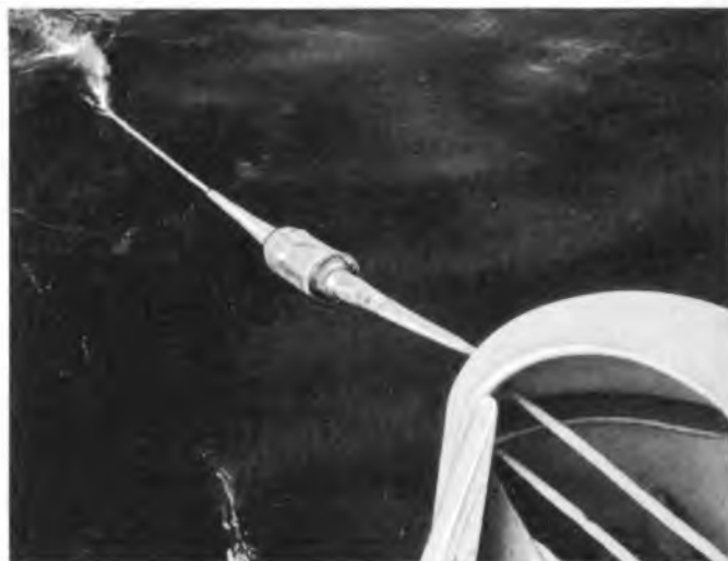
ICECAN Verstärker während der Legung
