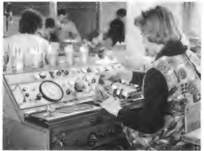
An diesem Arbeitsplatz im Ingolstädter Werk der NSF werden von geschickten Frauenhänden die elektrischen Betriebswerte der UHF-Tuner eingestellt
