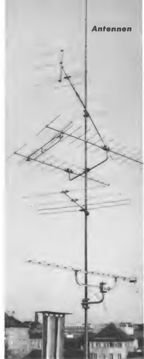
Bild 1. Das Antennengebilde auf dem Dach des Hochhauses. Da bei einer solchen Großanlage nur eine einzige den Witterungsunbilden ausgesetzte Dachanlage vorhanden ist, ergibt sich auch eine größere Wirtschaftlichkeit als bei entsprechend vielen kleinen Gemeinschaftsanlagen
