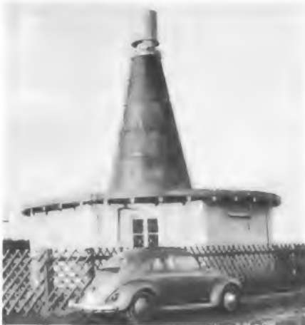
Bild 3. UKW-Drehfunkfeuer VOR mit TACAN-Zusatz in seiner heutigen Form (Anlage bei Fulda)
