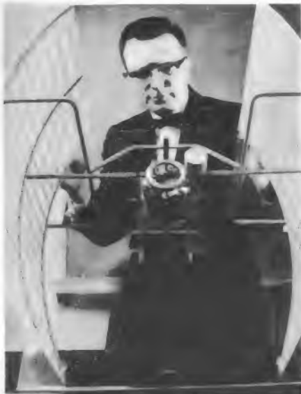
Nuclear-thermoelektrische Leistungsquelle für die ersten amerikanischen Mond-Sonden. Die Leistung beträgt 50 bis 60 Watt (Westinghouse Electric)
