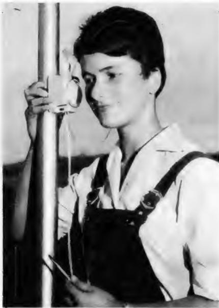
Bild 2. Die junge Technikerin bei der Montage einer Fernsehantenne. Durch das Antennensprechgerät erhält sie schnelle und sichere Anweisungen, wie die Antenne einzurichten ist. Mit einem Handgriff kann das Gerät nach Beenden der Arbeiten vom Mast entfernt werden
