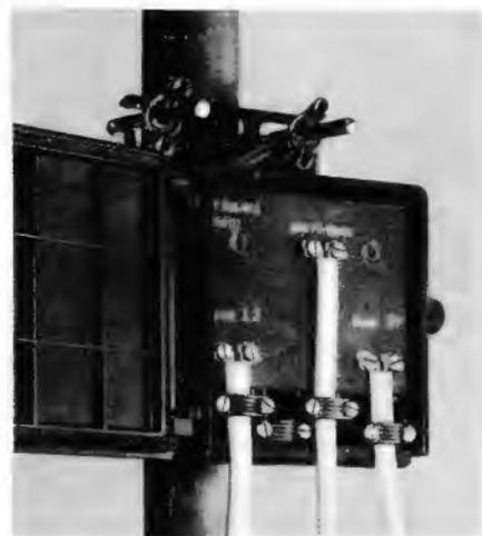
Bild 4. Bedienungsseite der Antennenweiche
