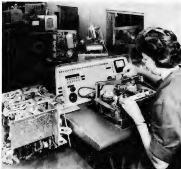
Fehler, die auf einer Prüfkarte registriert werden. Bis zu 50 Messungen führt das Gerät bei einer Wählerdrehung aus. Die Adapter sind für verschiedene Printplatten auswechselbar.
