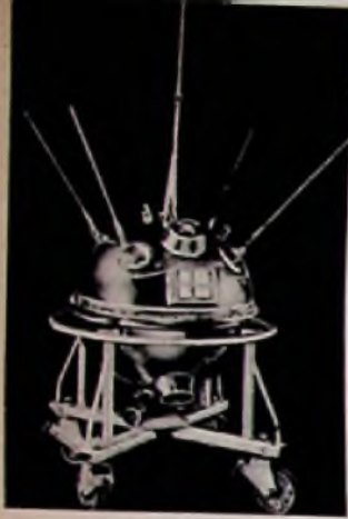
Instrumentenbehälter der russischen Weltraumrakete auf einem Transportwagen vor dem Einbau
