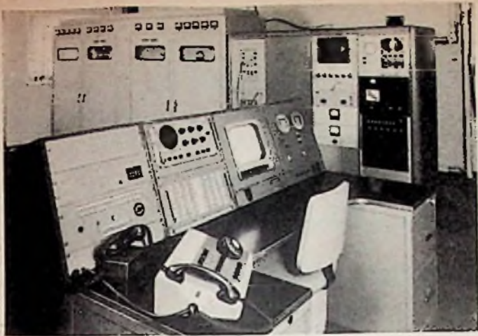
Das Kommandopult der Sendeanlage auf dem Säntis, im Hintergrund der Fernsehsender
