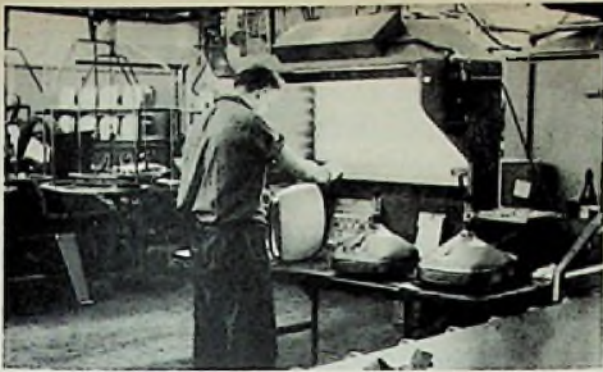
Äußere Endkontrolle der Bildröhre
