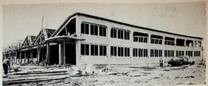
Neubau des Metz-Gehäuse- und Tonmöbelwerkes in Zirndorf
