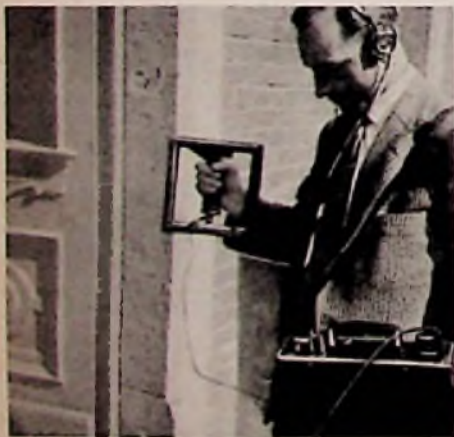
Bild 1. Schwarzfernseher-Suchgerät, entwickelt von der Fa. Wilhelm Quante, Wuppertal
