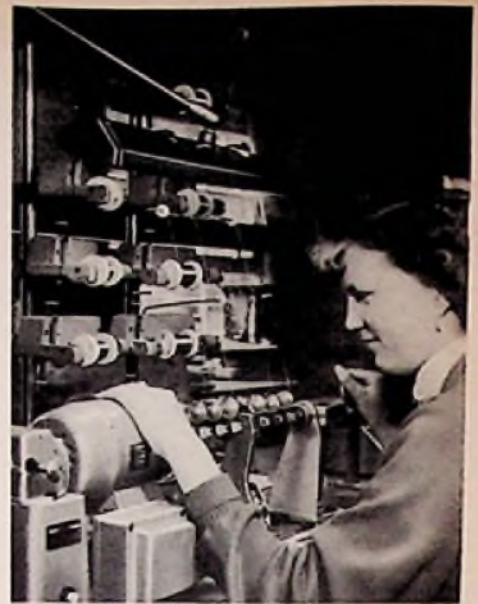
Sechs Miniaturübertrager entstehen gleichzeitig an dieser Feindraht-Wickelmaschine
