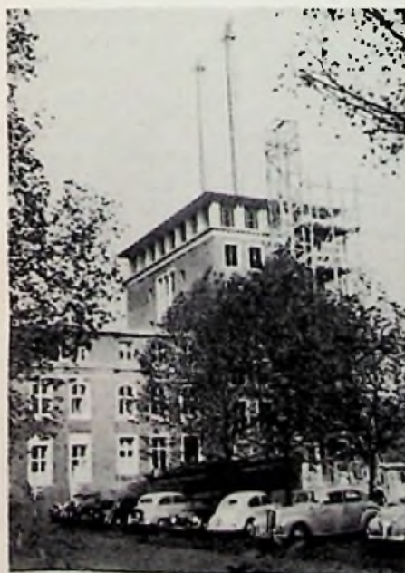
Richtfunk-Antennenmaste auf dem Verwaltungsgebäude der Hibernia-Bergwerksgesellschaft
