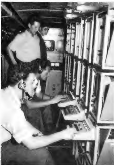
Blick in den Regiewagen des NWDR - Fernsehstudios. Ingenieure an den Kontrollgeräten
