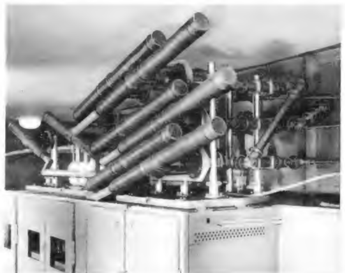
Kein Raketenwerfer, sondern das Einseitenbandfilter des neuen Lorenz-Fernsehensenders auf dem großen Feldberg. Es unterdrückt, wie der Name andeutet, das eine Modulations-Seitenband der Bildsenderfrequenz. Eine weitere Einrichtung, der Diplezer (links im Hintergrund), entkoppelt Bild- und Tonsender, so daß sie gemeinsam an eine Antenne angeschlossen werden können. Beide Einrichtungen sind in einer neuartigen Technik als „Brücken“ in Form koaxialer Ringleitungen ausgeführt
