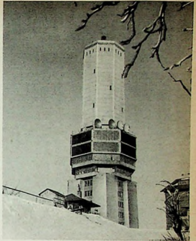
Der 72 m hohe Fernmeldeturm auf dem Großen Feldberg im Taunus. Der obere, ausschließlich aus Holz gefertigte Teil des Turmes dient zur Unterbringung der verschiedenen UKW-Rundfunk- und Fernseh-Antennen
