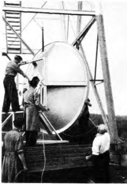
Telefunken ist fertig - Die Richtantennen der von Telefunken gebauten Teilabschnitte der Dezistrecke Hamburg-Köln, über die der NWDR am 1. Weihnachtstag das Hamburger Fernsehprogramm ins Ruhrgebiet und Rheinland übertragen wollte, wurden rechtzeitig montiert, aber die Verstärker konnten nicht aufgestellt werden, weil die von der Bundespost verpflichteten Baufirmen trotz Koksöfen - wie Dr. Gladenbeck mitteilte - die Räume nicht trocken bekamen. Erst Anfang Januar soll die Strecke betriebsbereit sein. Unsere Bilder zeigen Teilansichten des Telefunken-Bauabschnittes.
