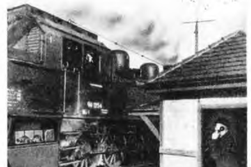
Bild 1. „Funklokomotive“ mit links unten eingebauten Sprechfunkgeräten und UKW-Antenne vor der Rangierzentrale mit Antennenanlage im Hintergrund
