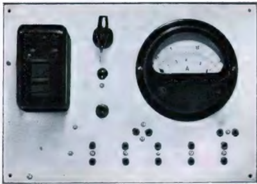
Bild 2. Praktischer Aufbau der Schalttafel.
