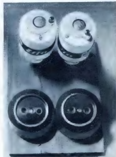
Das Brett mit den Steckdosen und den Elfa-Automaten. (Aufnahme: Vogler)
