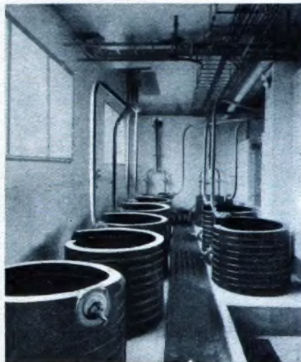
11 Das Röhrenkühlwasser muß destilliert sein. Das destillierte Wasser fließt ständig durch die Rückkühlanlage. Zum Kühlen des destillierten Kühlwassers wird gewöhnliches Wasser verwendet, das seinerseits wieder in einen Kühlturm gepumpt wird. In beiden Leitungskreisläufen fließt etwa 40 bis 60 cbm Wasser um.
