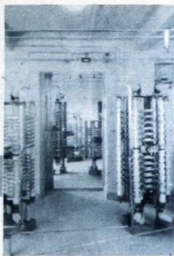
7 Die in der Endstufe erzeugte Hochfrequenzenergie wird über den Ausgangs-Abstimmkreis und über eine Stebkette an die Ausgangsleitung induktiv angekoppelt. Die bei der Verstärkung entstehenden Oberwellen dürfen nämlich nicht ausgefrüht werden, da sie starke Störungen des Kurzwellenverkehrs hervorrufen würden.
