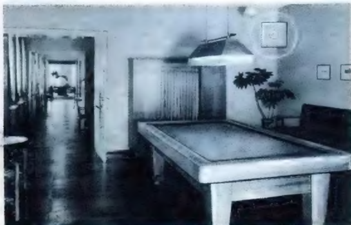
Schallwand-Lautsprecher im Gesellschaftszimmer eines Kurhauses. (Werkaufnahme: Körting-Radio)
