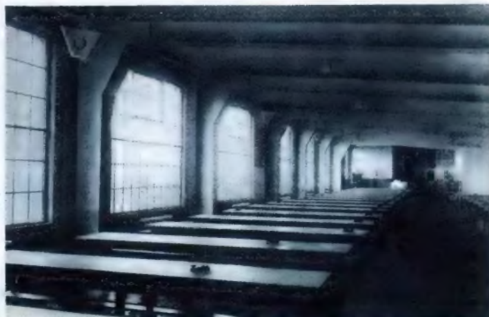
Lautsprecheranordnungen im Gesellschaftssaal einer Maschinenfabrik. (Werkaufnahme: Körting-Radio)
