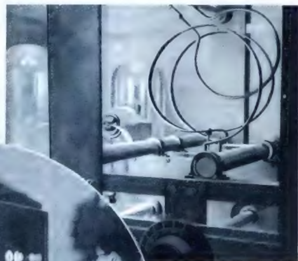
Die Endstufe des Senders mit den Kopplungspulen für die Ankopplung der Antenne.
