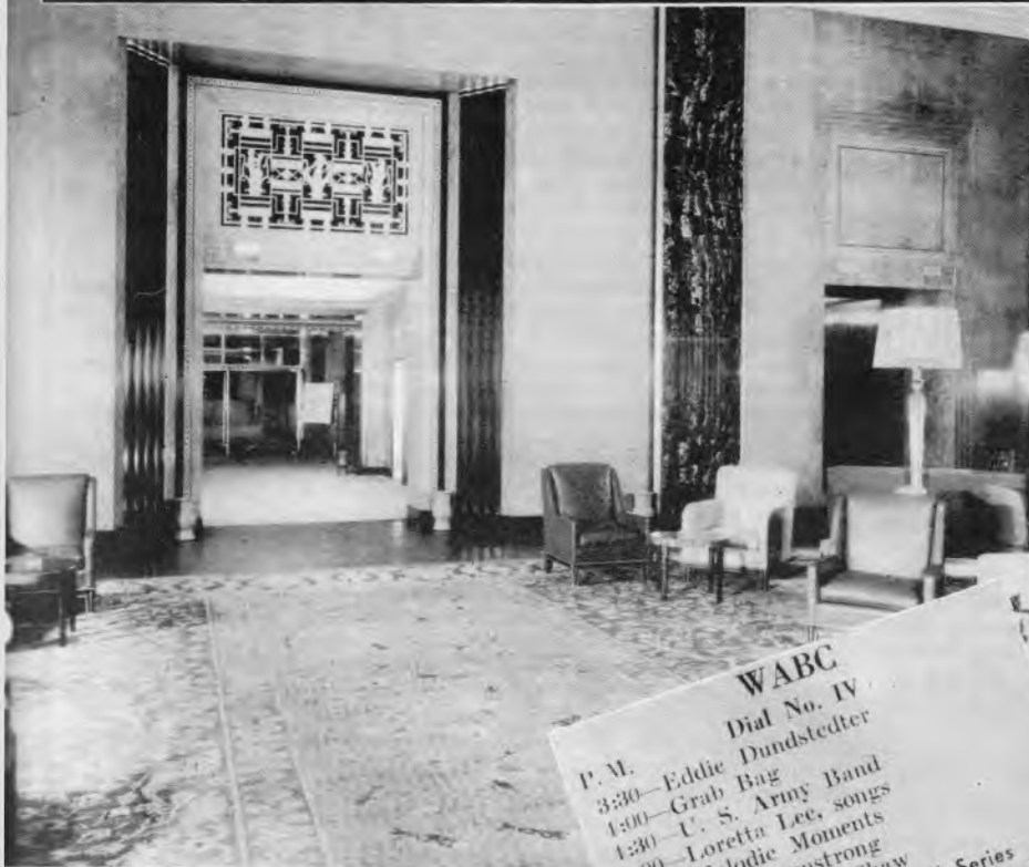
Abb. 3. Ecke aus der Empfangshalle. Der an die Radiozentrale angechlossene Groß-Lautsprecher befindet sich über der Durchgangstür hinter der Schmuckverkleidung.
