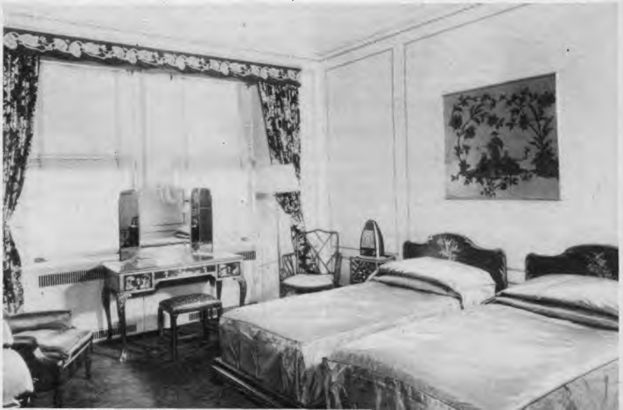
Abb. 2. Das Standardzweibettzimmer des Hotels. Auf dem Bett-Tischchen der Lautsprecherapparat, links der Knopf für die Programmwahl, rechts die Lautstärkeregelung, unter der Verzierung der Lautsprecher.
