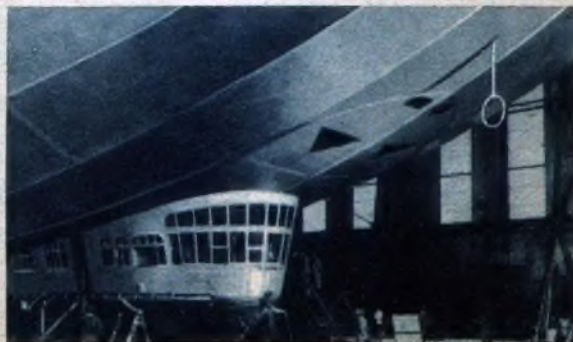
Der Peilrahmen, der bei Bedarf ausgeschwenkt wird.
