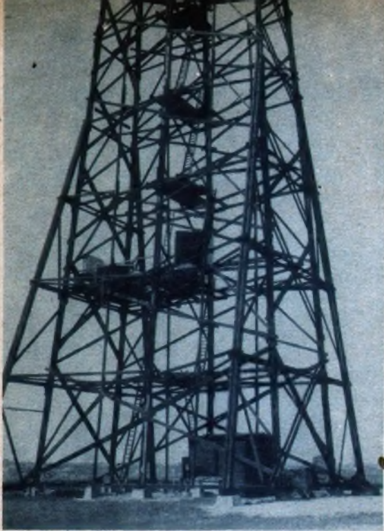
Einer der 30 m hohen Holzgerüsttürme für Schallausbreitungserfahrungen.
