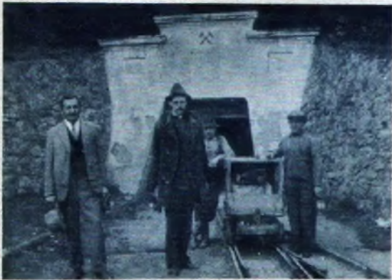
Der Hunt mit dem Empfänger fertig zur Einfahrt in die Grube. (In der Mitte der Verfasser)
