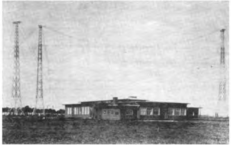
Das Kurzwellensenderhaus in Nauen, dahinter eine Strahlwerfer-Antenne
