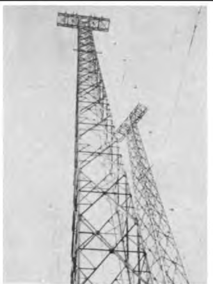
Gigantische Stahlkonstruktionen sind die neuen Antennenmasten.
