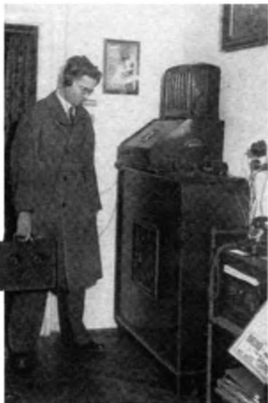
Der Funkhelfer nimmt die „Witterung“ auf er hört sich das Störgeräusch in seinem Suchgerät an am Ort der gestörten Empfangsanlage.
