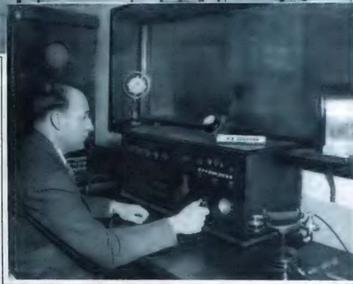
Der Apparat mit den Kontrolleinrichtungen, der Tonregulierung und der Einrichtung für Entstörung, der die deutschen Sendungen in Amerika aufnimmt.
