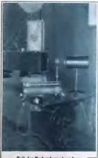
Teil des Farbenfernsehensenders. Rechts die Beleuchtungseinrichtung, links der Tubus für die Farbabtastung.
