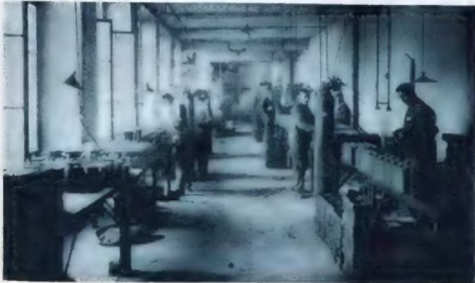
Teil des Spezial-Einbaues einer Akkumulatorenfabrik.
