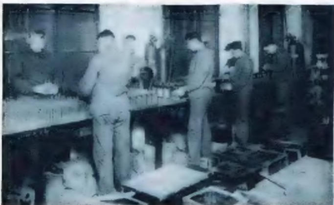
Der Einbau von Glaselementen.
