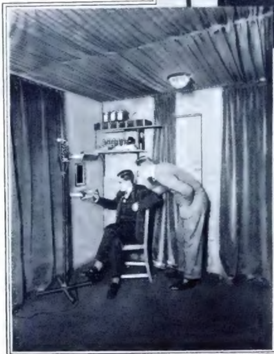
Die jüngsten Versuche mit dem Television-Verfahren haben die Notwendigkeit ergeben, die Wände des Laboratoriums mit Messing zu belegen, um eine Interferenz der verschiedenen Apparaturen im Laboratorium zu vermeiden. Phot. Telna
