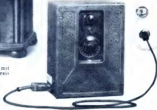
Der „Ober-Land und Mehr“-Empfänger von Neufeldt & Kuhnke, für 220 Volt, 2 Röhren. Preis mit Röhren M. 193.50.
