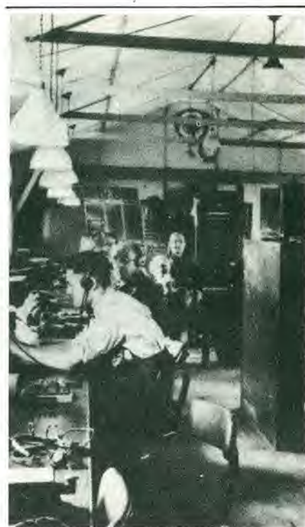
Figura 4. Una delle stazioni di controllo delle Special Communications, per i collegamenti con l'Europa occidentale.
