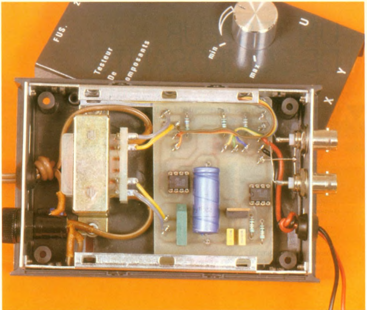
Photo 2. – Aperçu du montage introduit à l'intérieur d'un coffret « Retex ».
