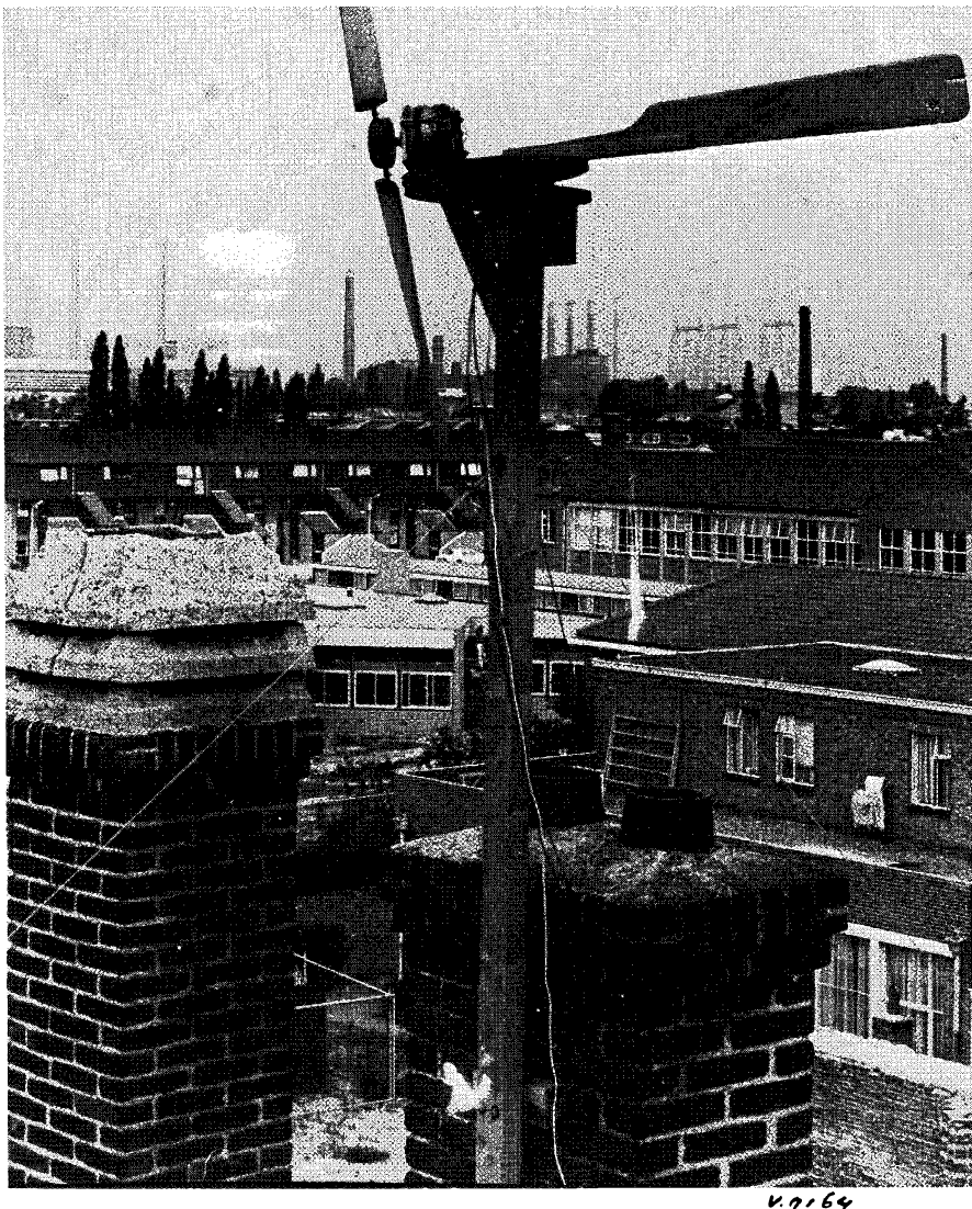
Fig. 5. Voorbeeld van een windmolen die nauwelijks een meter boven de nok van het dak staat. Tevens krijgt u nu een indruk hoe zo iets in de stad eruit ziet. Jaaropbrengst ca. 350 kWh. Plaats: een kraakpand in Nijmegen. Op de achtergrond de nieuwe kolencentrale van de PGEM te Nijmegen. (Foto: 'Hans').
