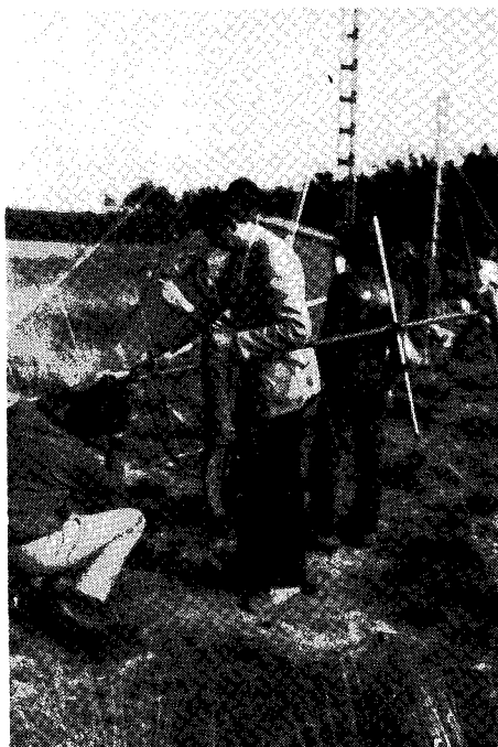
2. Boven de rotor is een twee meter lange hulpmast met daaraan zijdelings aangelaste armen gemonteerd. Aan de hulpmast en de draag-armen zijn de diverse antennes bevestigd (ze staan niet allemaal op deze foto).
