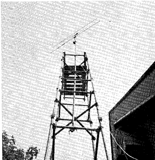
De antennetoren van PAoHVA. Tijdens contesten wordt de mast nog 2,5 meter naar boven gedraaid en staat de antenne zo'n 23 meter boven de grond. Op de foto is de antenne nog een 9 x 9. Deze is inmiddels vervangen door een 16-elementen voor 2 m en een 70 cm antenne. (Foto: PAoHVA)
