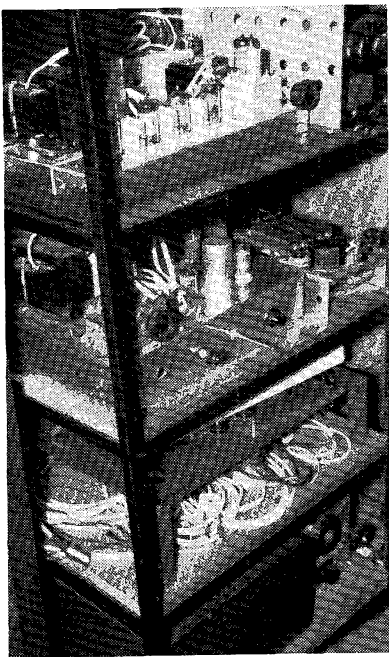
Foto 1: De apparatuur van het luisterstation NL-919
