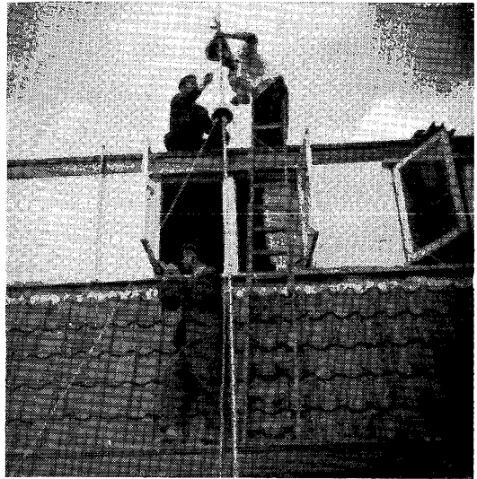
De antenne van PAoDIC. Dit is een foto van de oprichting van de antennemast van PAoDIC in Hilversum. De mast is negen meter lang met bovenin de long Yagi voor 70 cm (beschreven in Electron) en 1½ meter lager de WISA-Click. Op de foto ziet u PAoJPH (links boven), PAoDIC (rechts) en in de dakgoot PAoMW. De overige (onmisbare) helpers, niet op de foto, waren PAoZE en OM Bente Bordes. Toeschouwers waren de x.1 van PAoJPH en de QRP. De thee en de foto: mevr. Sauer
