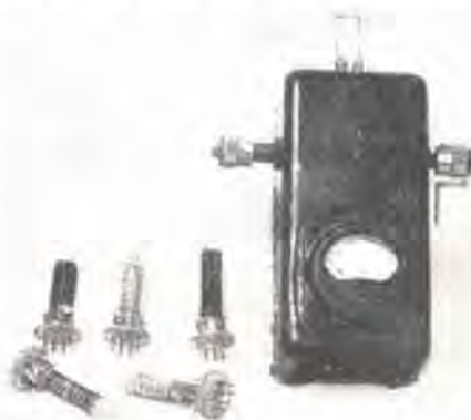
Ondametro con la serie di bobine da impiegare per le varie gamme di frequenza.
