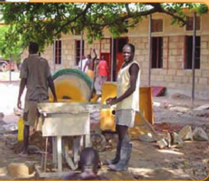
Vista del progreso de la construcción en la escuela media para chicas de Rumbeck, Sur del Sudán. La Orden de Malta y el equipo de 1A3A impulsaron el avance del proyecto. (Foto cedida por la web de 1A3A).
