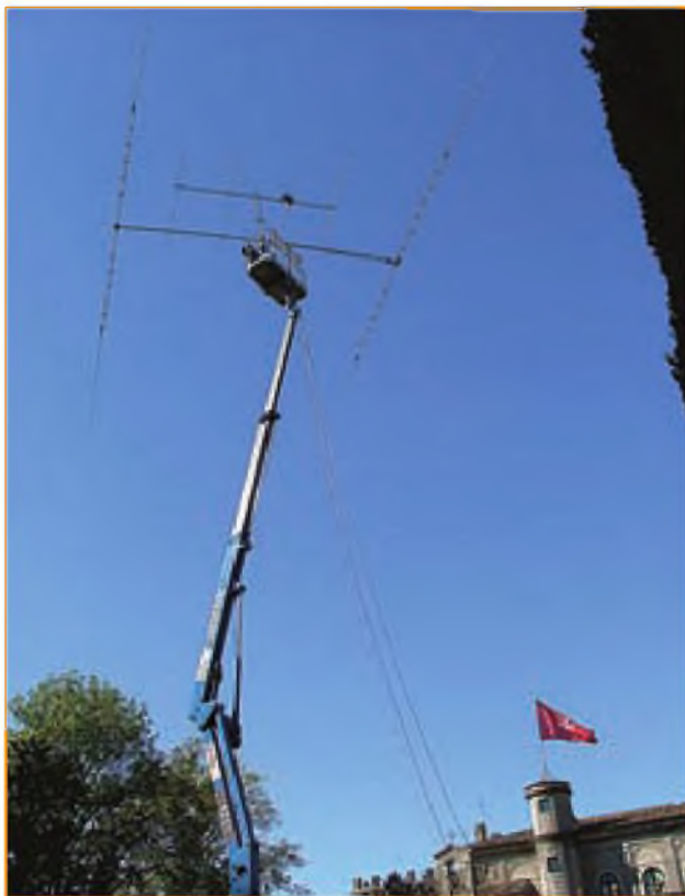
Foto 2. Las directivas de 10 y 40 m fueron instaladas en una plataforma de un camión grúa alquilado y encaradas en direcciones opuestas. Véase el texto para más detalles.
