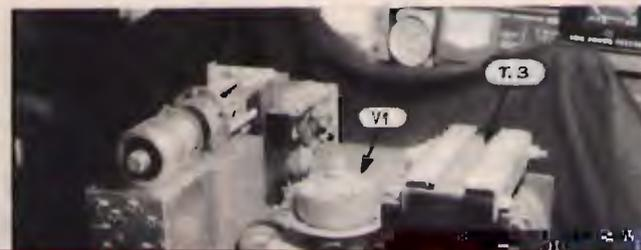
⑨ "Assemblaggio... si pone in sede il trasformatore di alta tensione T.3. Anche la valvola viene collocata per prova nella sua sede".
