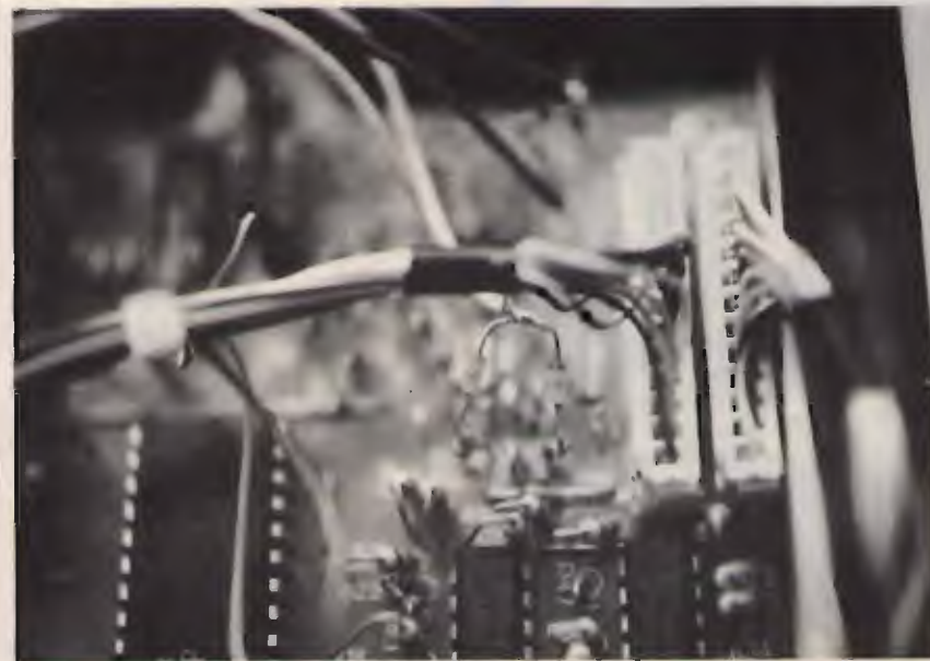
foto 5 I diodi aggiunti Da-1 e DA-2 saldati rispettivamente su D-55 e D-57.
