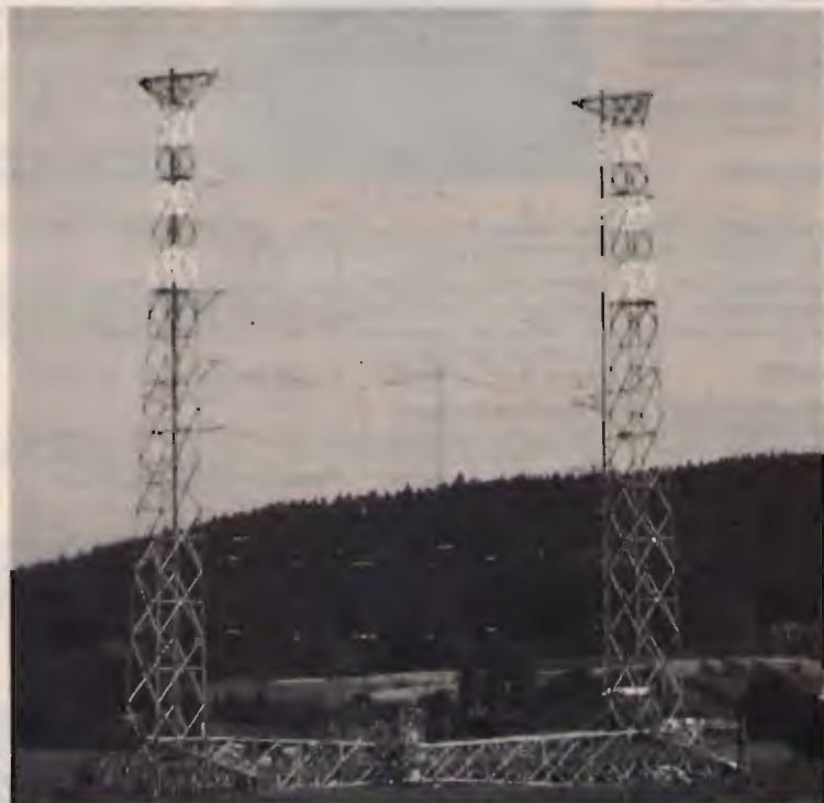
Antenna a cortine per onde corte, su traliccio rotante.
