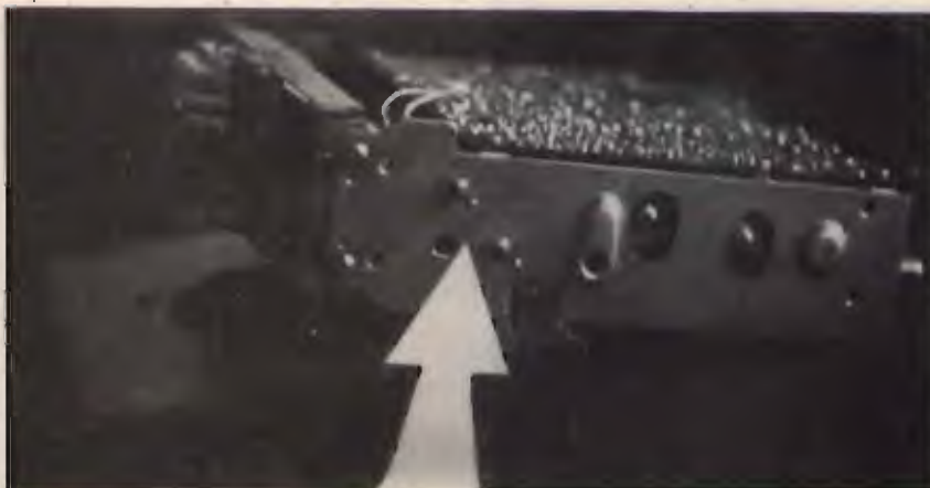
foto 3 Posizione degli interruttori sul telaio.
