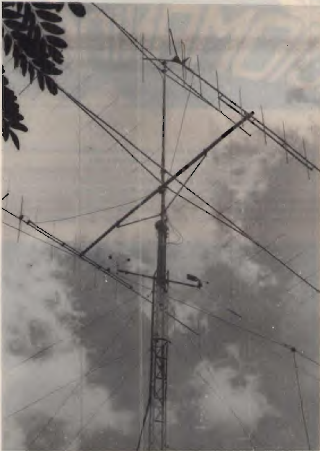
La "Doppia Vela" costituisce una efficace rete di guardia contro il maltempo. Per chi possiede un "parco antenne" di rilevanti dimensioni è sempre consigliabile orientare le stesse nella direzione in cui offrono meno resistenza ai venti.
