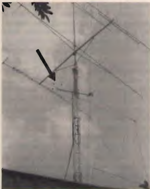
Il sensore dell'anemometro va collocato nel punto più alto del traliccio, in una zona esposta ai venti.
