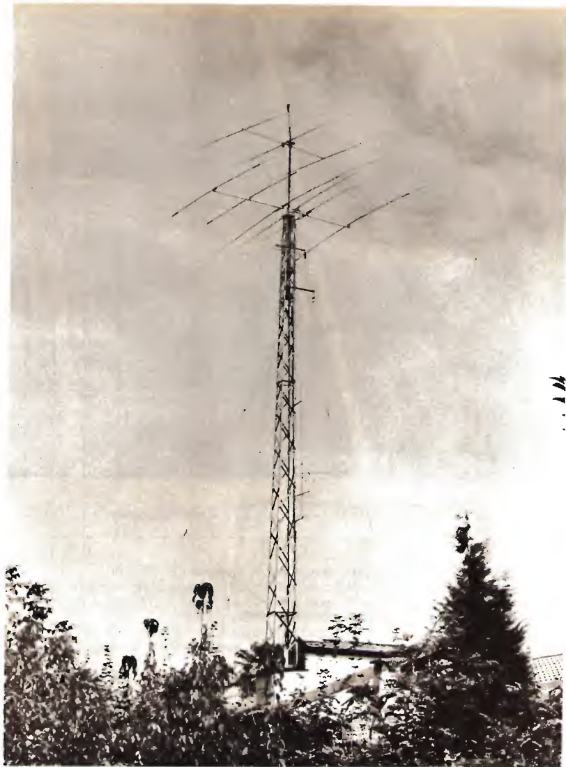
L'antenna 3F36DX montata sulla sommità del traliccio. Sono stati presi degli accorgimenti affinché l'antenna superiore a 3 elementi risonante sui 28 MHz non influenzi la misura. Lo «spazio libero» è stato abbastanza bene simulato in quanto il tetto della casa dista una lunghezza d'onda alla frequenza più bassa (14 MHz).
