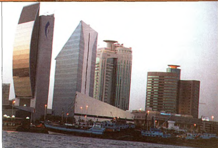
Les immeubles de Dubaï sont remarquablement modernes avec peu d'architecture traditionnelle. Je ne m'attendais pas du tout à cela dans ce pays. (Photo de K2RED)
