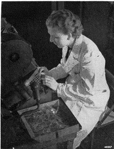
Fig. 66 Het stansen van de in de buizen toegepaste mica plaatjes.
