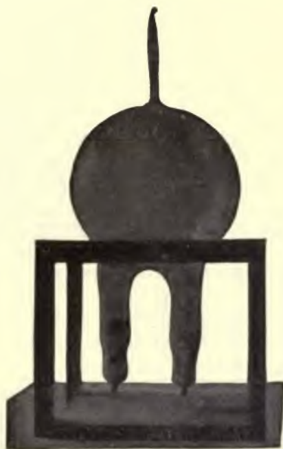
FIG. 124.—MERCURY VAPOR INTERRUPTOR.
